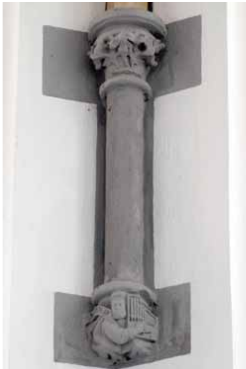
Afb. 61) LINKS: een van de acht combinaties van een kapiteel met bladwerk (boven) en een kraagsteen met figuratieve voorstelling (onder) in de Van Balverenkapel.
