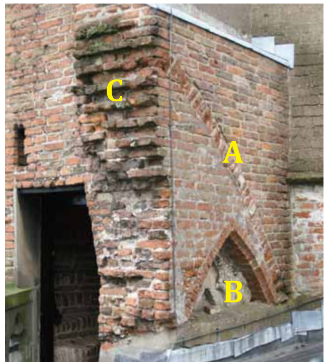
Afb. 26) RECHTSONDER: bouwsporen op de Varkenstoren van een gewelfinkassing (A), een blindvenster met maaswerk (B) en een staande tand (C) waarop de beoogde uitbreiding had zullen aansluiten.
