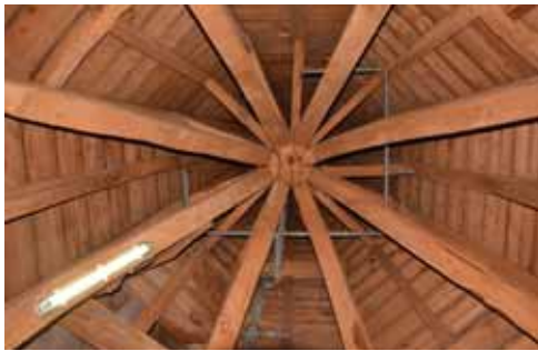
Afb. 30) LINKSBOVEN: onderaanzicht van de spitsconstructie op de Varkenstoren.
