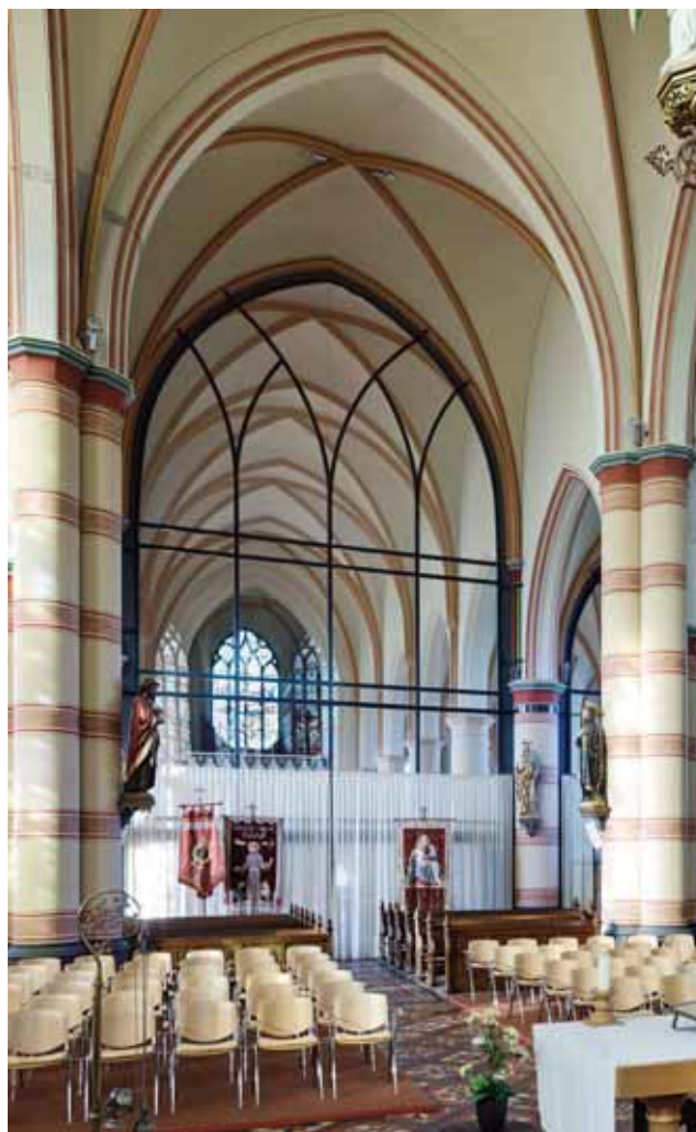
Afb. 133) Als voorbeeld: de glazen afscheiding in de triomfboog van de St.-Martinuskerk in Baak. (RCE)
