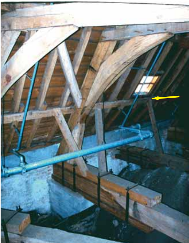
LINKSBOVEN: bij de bouw van de nieuwe zijbeuksdaken (A) werden de oude (B) geleidelijk gesloopt. (RAR)
